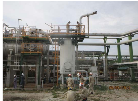
ปล่อง Charcoal Adsorber 5 (V-9104)
